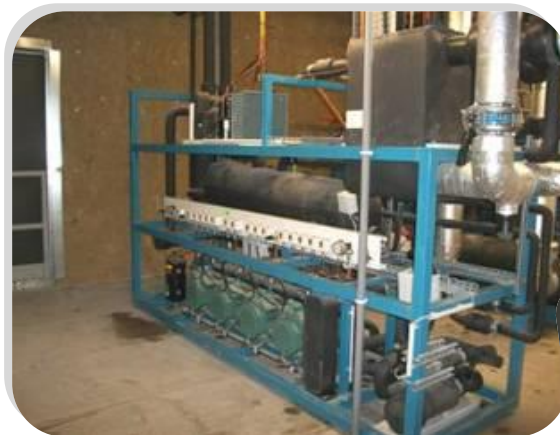
Condensation sur la boucle d'eau glacée
