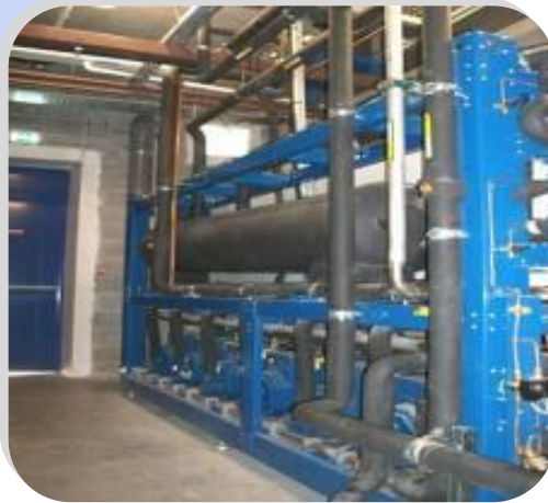
Centrales positives semi hermétiques transcritiques avec récupération de calories pour le chauffage
