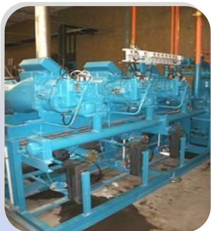
Centrale à vis avec économiseur
