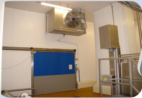
Conditionneur inox pour salle de travail
