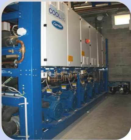
Centrales positives semi hermétiques transcritiques avec récupération de calories pour le chauffage
