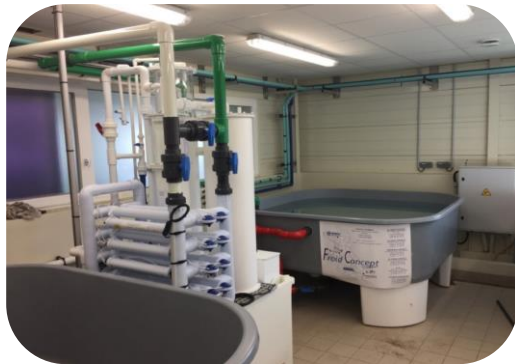
Process aquacole avec filtration biologique et mécanique, refroidissement, réseau air lift, traitement UV Lycée de la Mer et du Littoral Bourcefranc (17)
