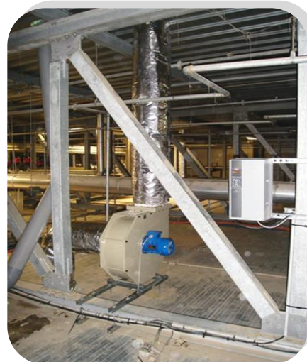
Extracteur d'air en polypropylène
