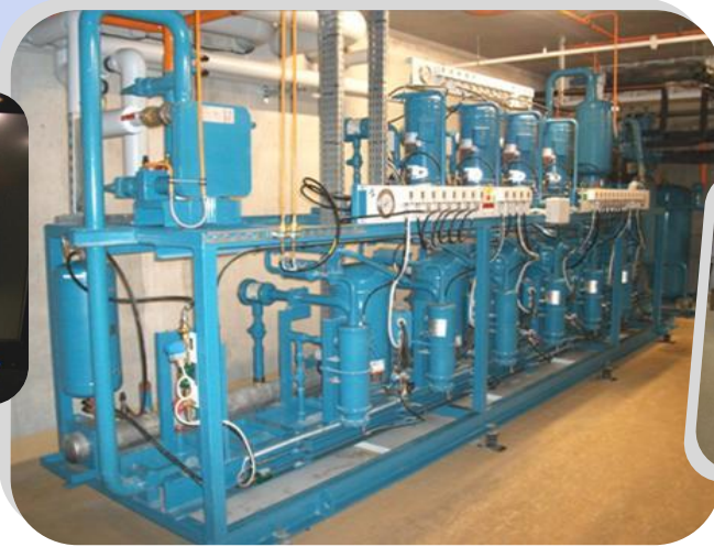
Production R404 en boosters hermétiques Scroll
