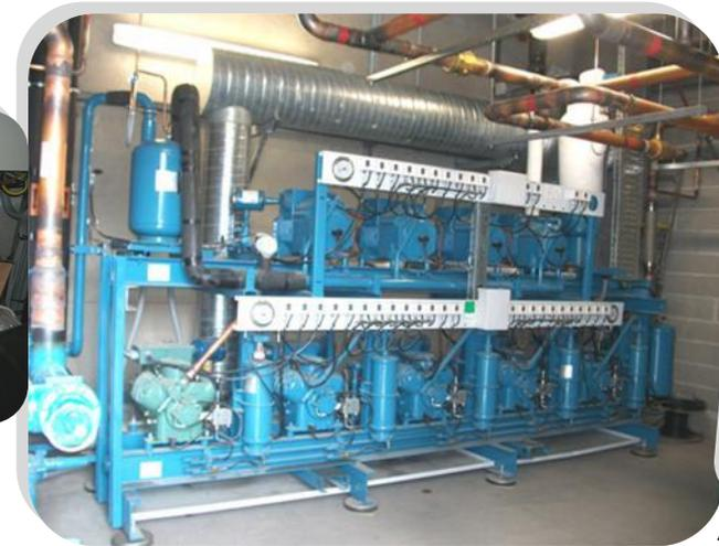
Production R404 en boosters semi-hermétiques avec variateur de vitesses 30/70Hz sur l'étage MP
