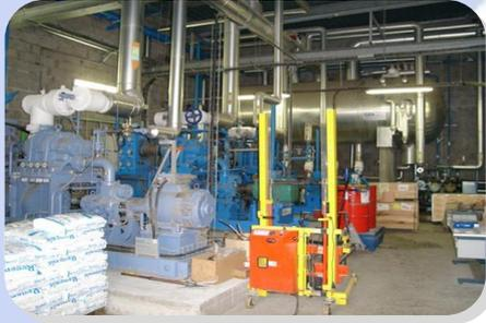
Salle des machines 1000kW au NH3 à -42°C
